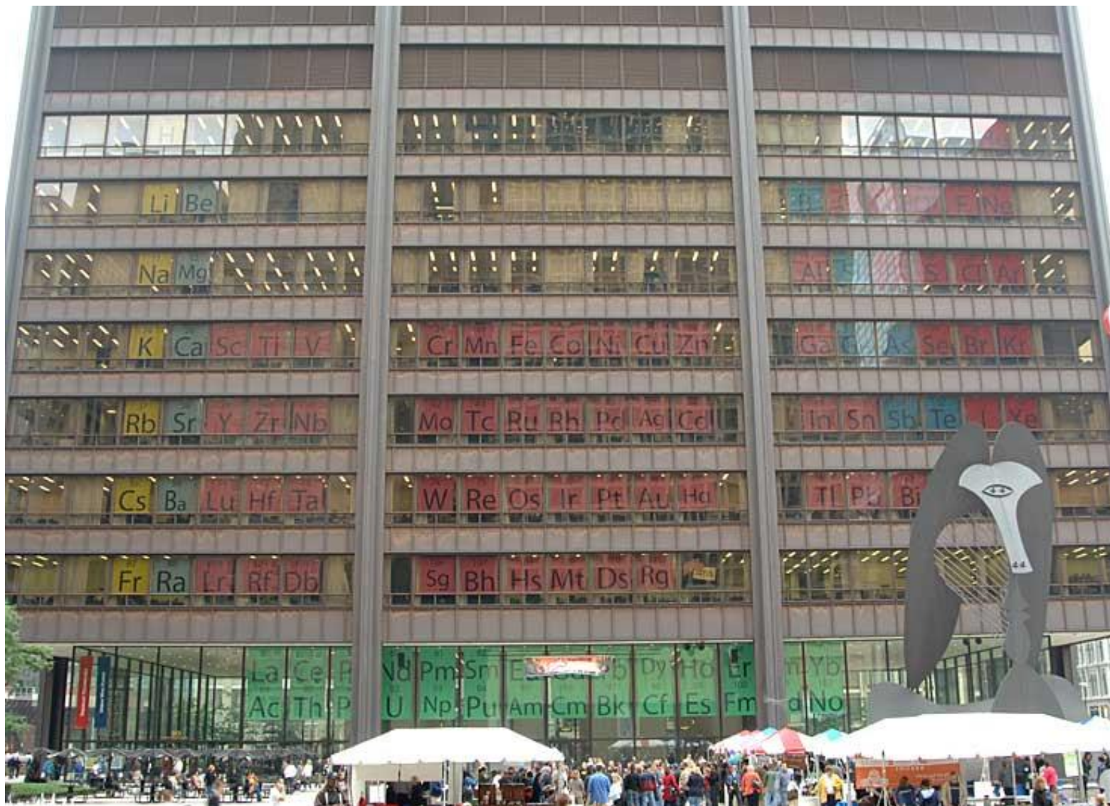
Daley Center, Chicago (USA)
